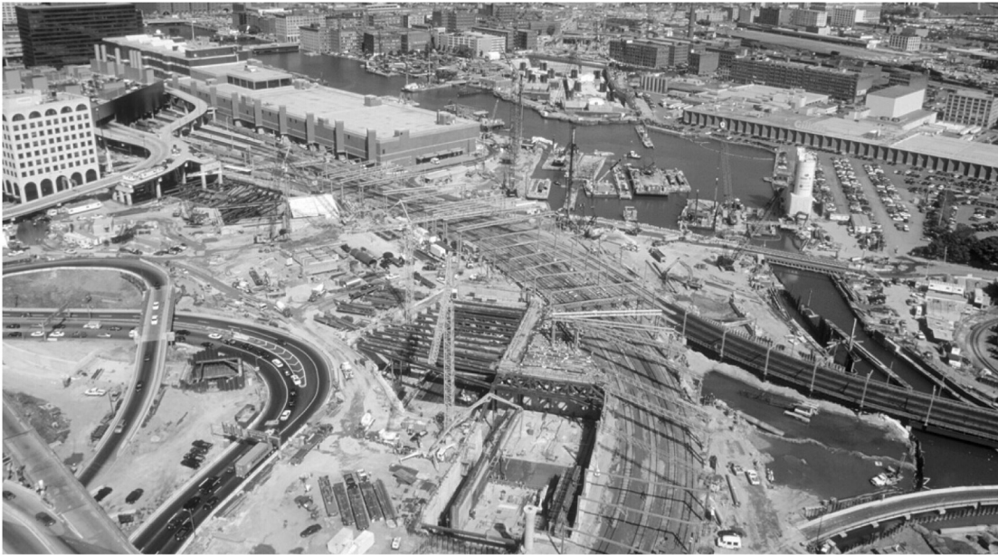
Big Dig 공사 전경. (출처 : construction equipment guide.com)
